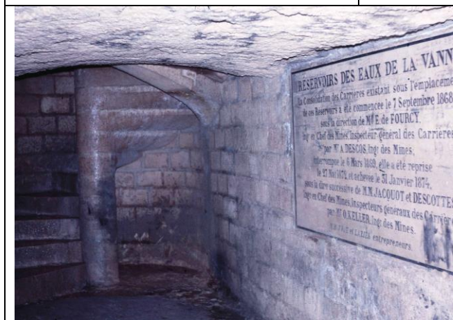
67_06-B07-sous le Réservoir de la Vanne
