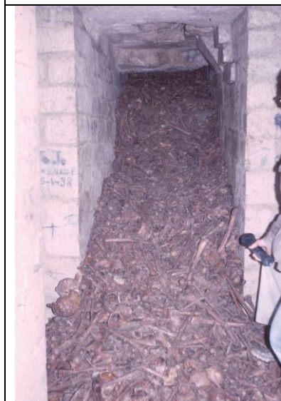
67_06-B03-rotonde Montparnasse : déversoir
